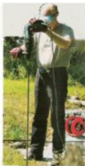
klopboormachine inhameren v. grondstaaf
